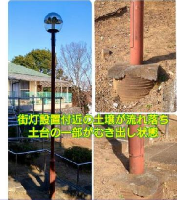
街灯設置付近の土壌が流れ落ち、土台の一部がむき出し状態
